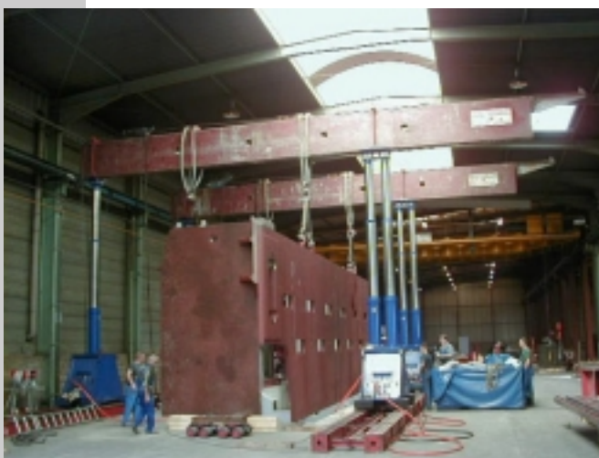
Bild 4 Einbau der Unterwange, Gewicht 44 to
