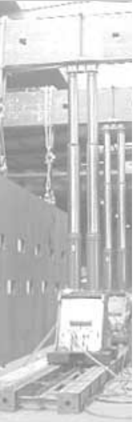
Bild 2 Einbau der mittleren Unterwange
