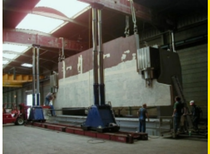
Bild 1 Einbau der Oberwange 120 to
