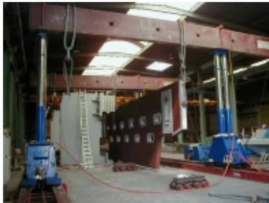
Bild 2 Einbau der mittleren Unterwange
